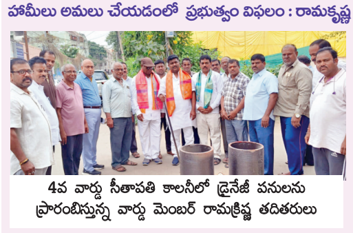
4వ వార్డు సీతాపతి కాలనీలో డ్రైనేజీ పనులను ప్రారంభిస్తున్న వార్డు మెంబర్ రామకృష్ణ తదితరులు
